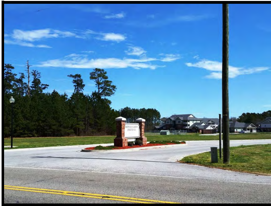
Site Entryway (Phase I)
